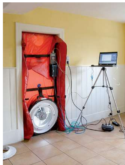
Kontrola budov se provádí i z pohledu vzduchotěsnosti s měřicím zařízením Blower Door test
