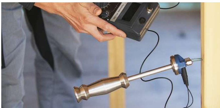
Vlhkost se může měřit i v konstrukci pro detekci nevhodně provedených konstrukčních detailů.
